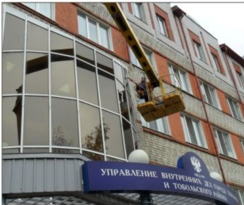
Фасад УВД «Тобольское» (мытьё окон)
